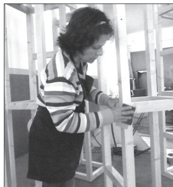
Cinco días de trabajo en la bodega-taller: cortando y dando forma
